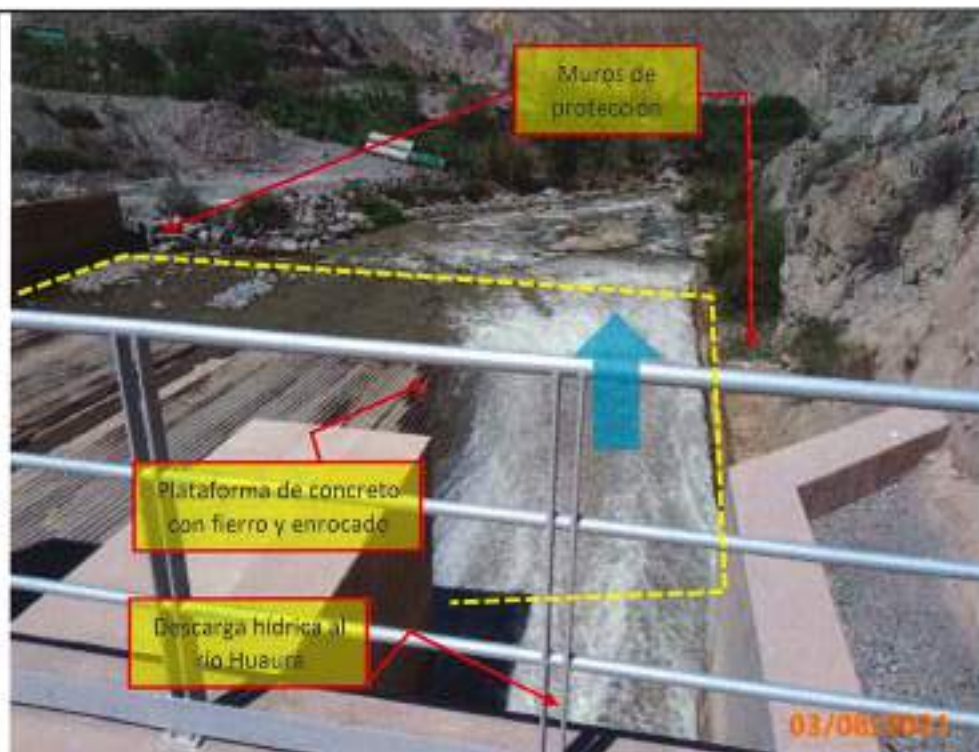
Fotografía N° 11: Descarga hídrica desde la presa Picunche sobre una plataforma de concreto y perfiles de metal. Se observan los muros de protección de concreto armado en la margen izquierda y derecha del río Huaura.
