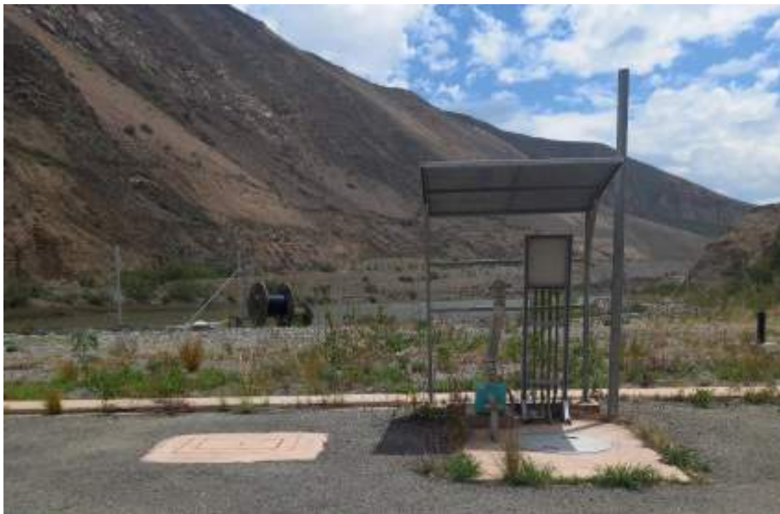
Fotografía 6.2-5 Pozo ciego 1-Presa Checras (PAD-CHE-04b)
