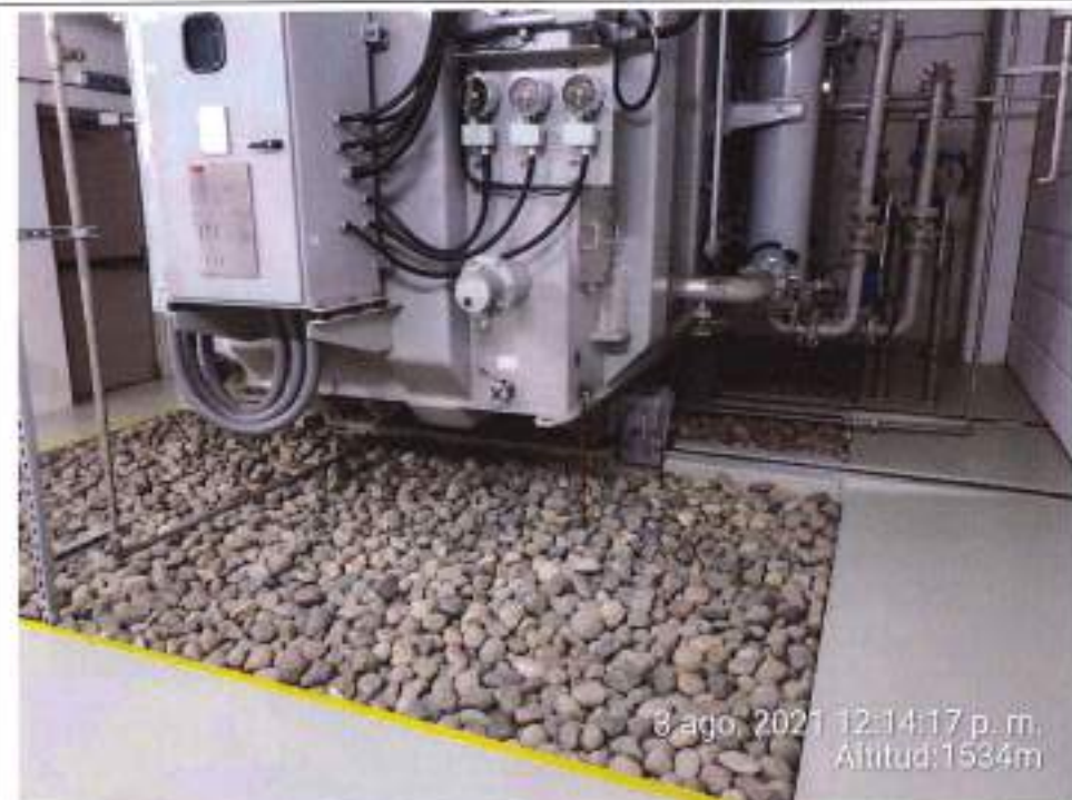
Fotografía N° 3: Transformadores de potencia 1, instalado en caverna donde se aprecia el pozo de contención cubierto con piedra chancada. No se evidenciaron rastros de fugas o derrames de aceites.
