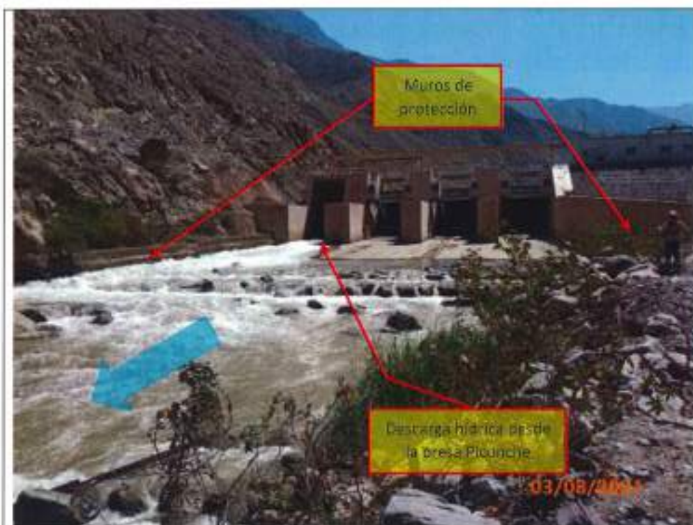
Fotografía N° 12: Otra vista de la descarga hídrica desde la presa Picunche. Se observan los muros de protección en la margen izquierda y derecha del río Huaura.
