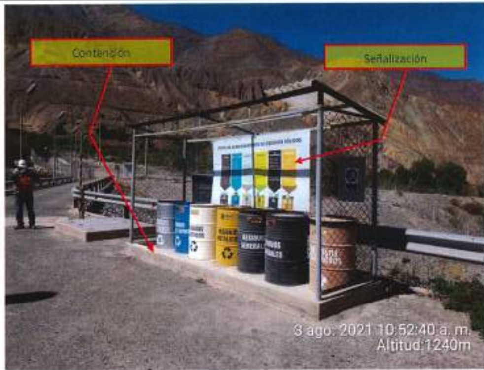
Fotografía N° 20: Punto de almacenamiento inicial o primario del reservorio Picunche, se observa la estructura parcialmente techada, contención (poza ciega en caso de derrames) y señalización.
