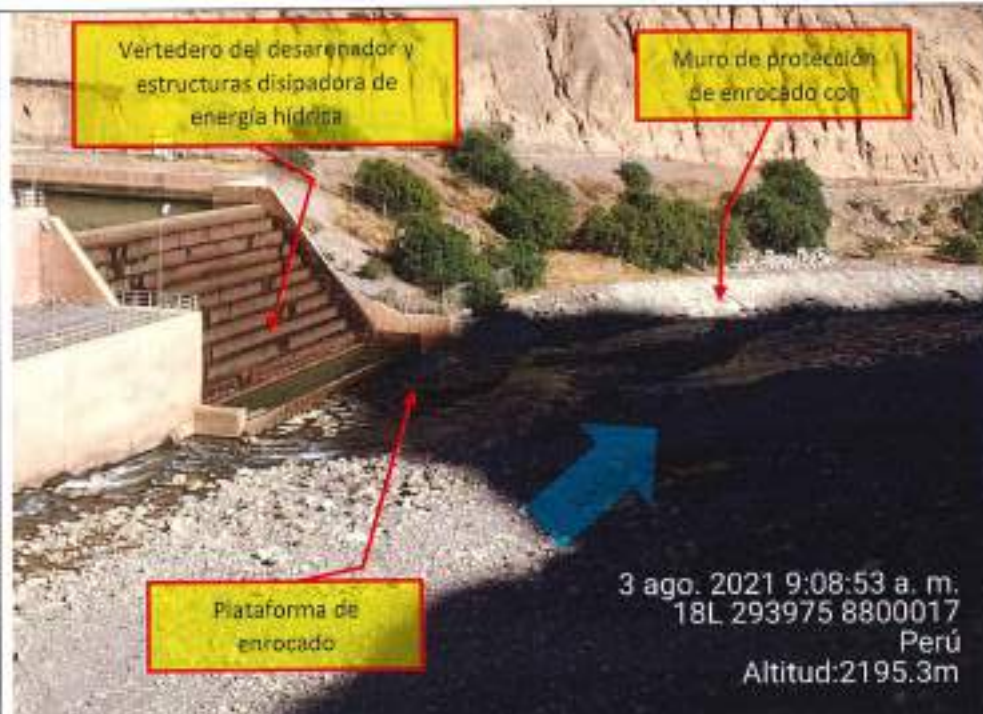
Fotografía N° 10: Vertedero del desarenador con sistema de disipadores de energía hídrica y muro de protección (enrocado con concreto) en la margen izquierda del río Checras.
