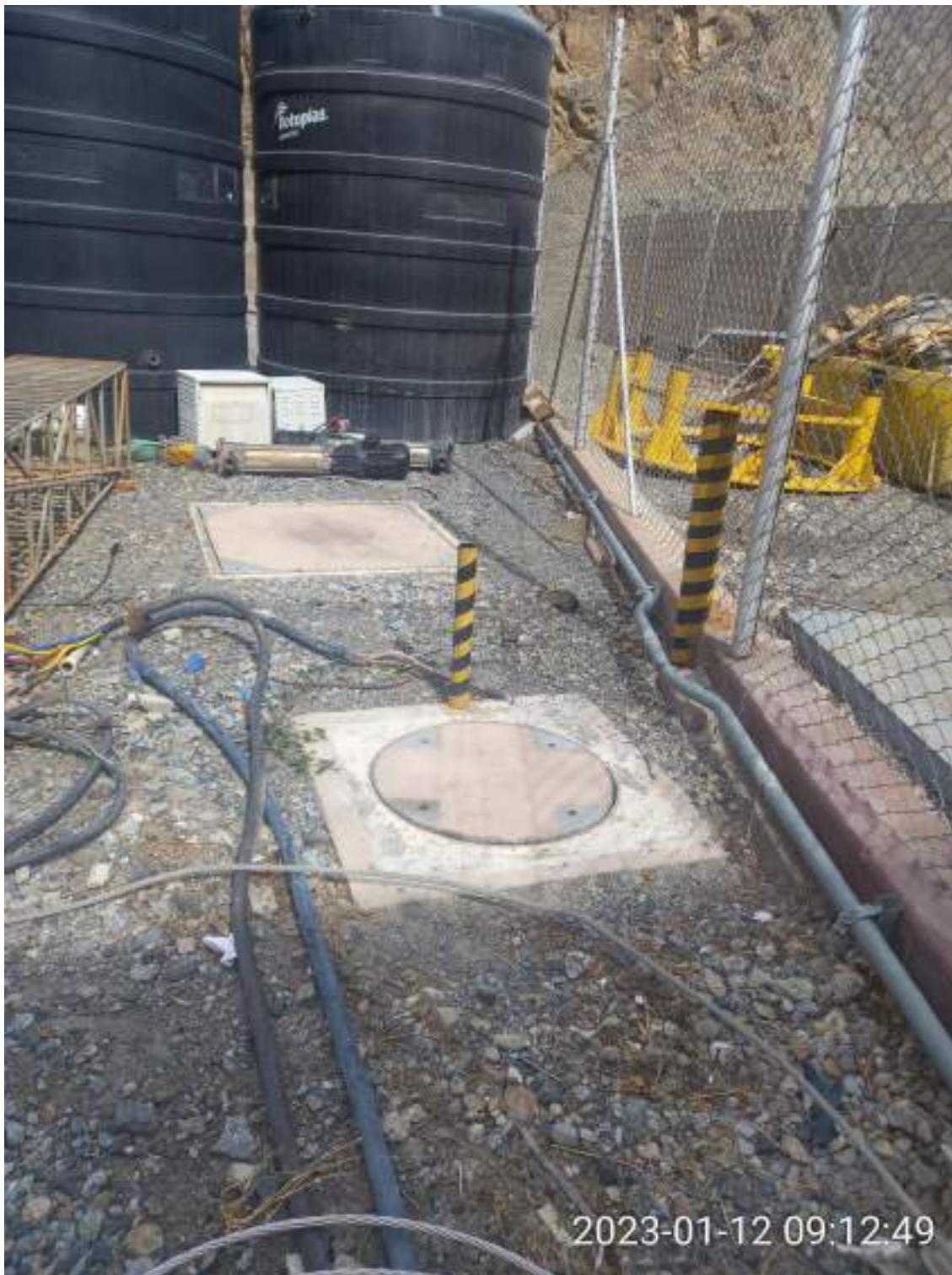
Figura 3-22 Vista actual del pozo ciego 3 (SE Cheves y CH Cheves)
