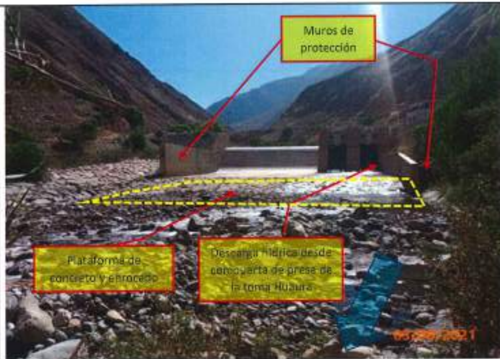
Fotografía N° 7: Vista general de la toma Huaura, en donde se observa muros de protección en ambas márgenes del río Huaura; así como una plataforma de concreto con fierro y enrocado (cama de piedra) que recibe la descarga hídrica.
