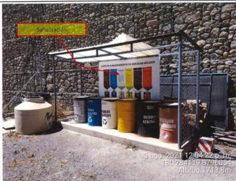
Fotografía N° 22: Punto de almacenamiento inicial o primario ubicado frente al patio de llaves de la casa de máquinas de la C.H. Cheves, se observa la estructura parcialmente techada, contención (poza ciega en caso de derrames) y señalización.
