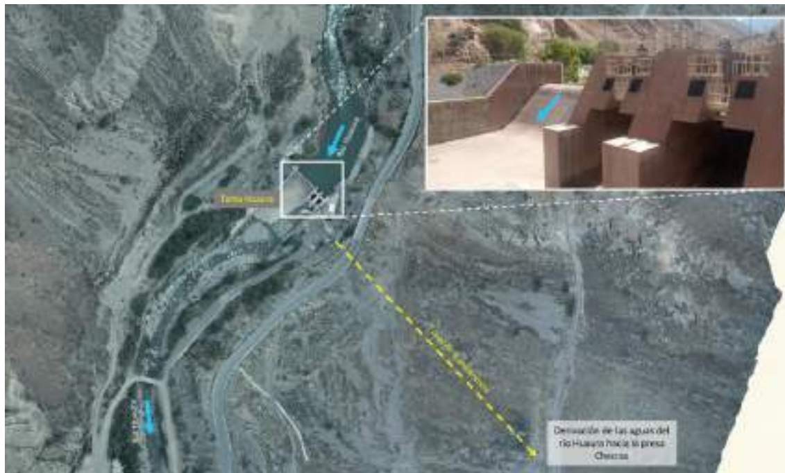
Figura 5-1 Captación de las aguas del río Huaura y derivación hacia la presa Checra
