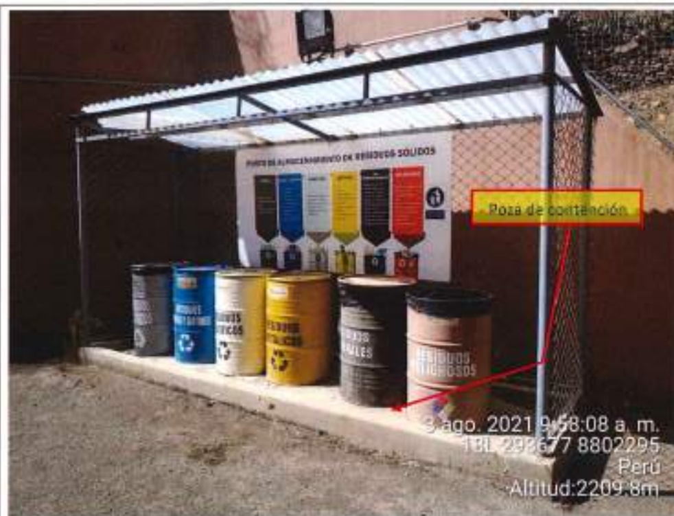
Fotografía N° 19: Contenedores de metal al interior de una poza de contención de concreto, no se observa fugas o derrames en el punto de almacenamiento inicial de la toma Huaura.
