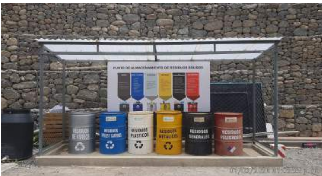
Fotografía 3-7 Punto de acopio de residuos sólidos: SE Cheves / CH Cheves
