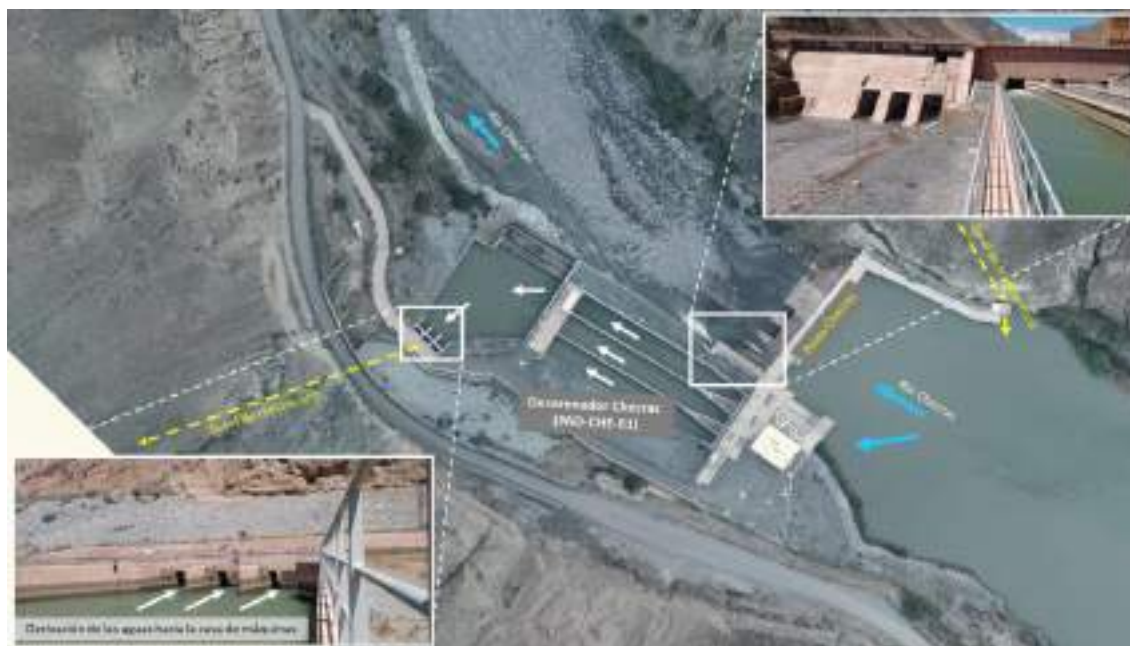
Figura 5-2 Captación de las aguas del río Checras
