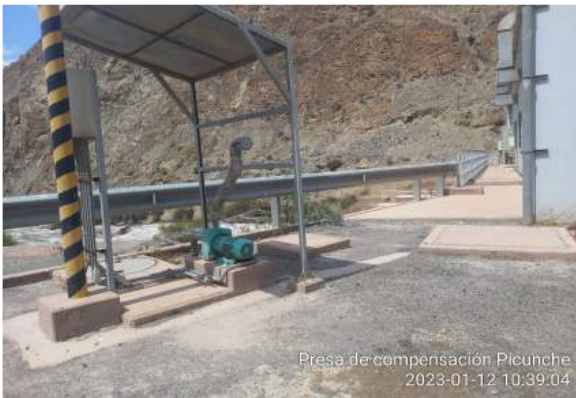
Fotografía 6.2-6 Pozo ciego 4-Reservorio Picunche (PAD-CHE-04d)
