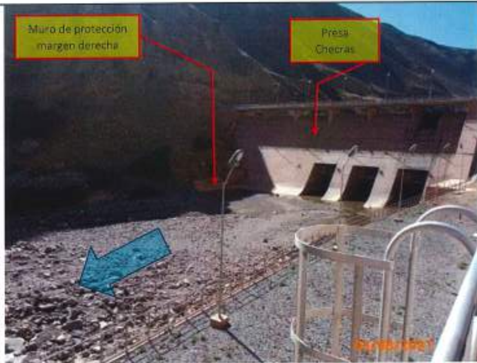
Fotografía N° 9: Presa Checras, en la margen derecha del río Checras, se observa el muro de concreto
