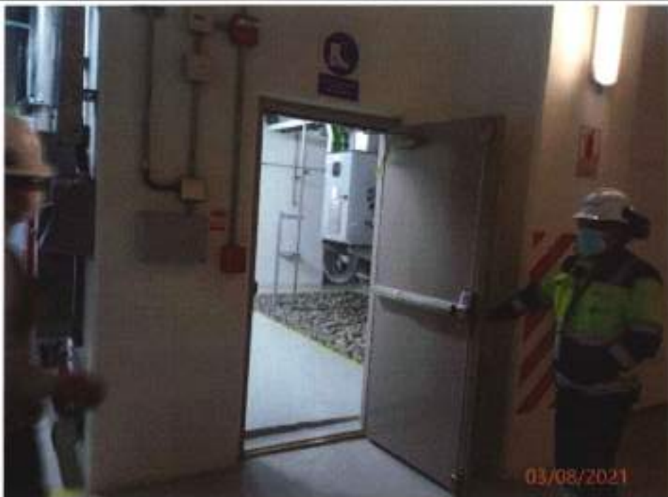
Fotografía N° 4: Vista de la puerta de ingreso al ambiente donde se encuentra ubicado el transformador de potencia 2.
