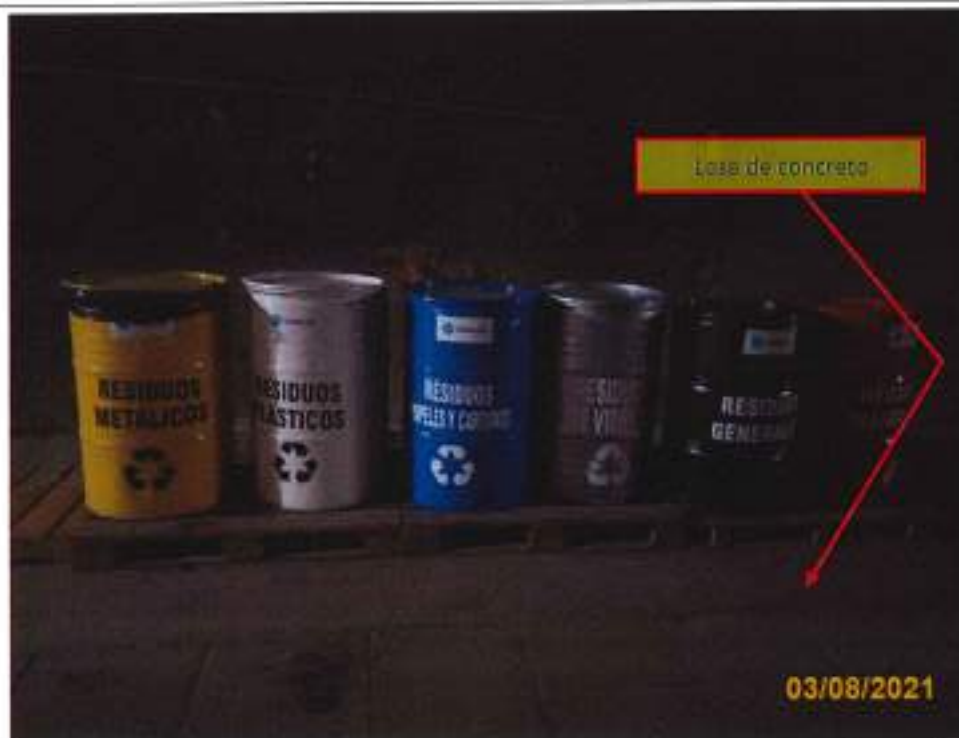
Fotografía N° 25: Contenedores de metal rotulados y con tapa, se observa que los pallets se ubican sobre losa de concreto, no se observa residuos o derrames alrededor.
