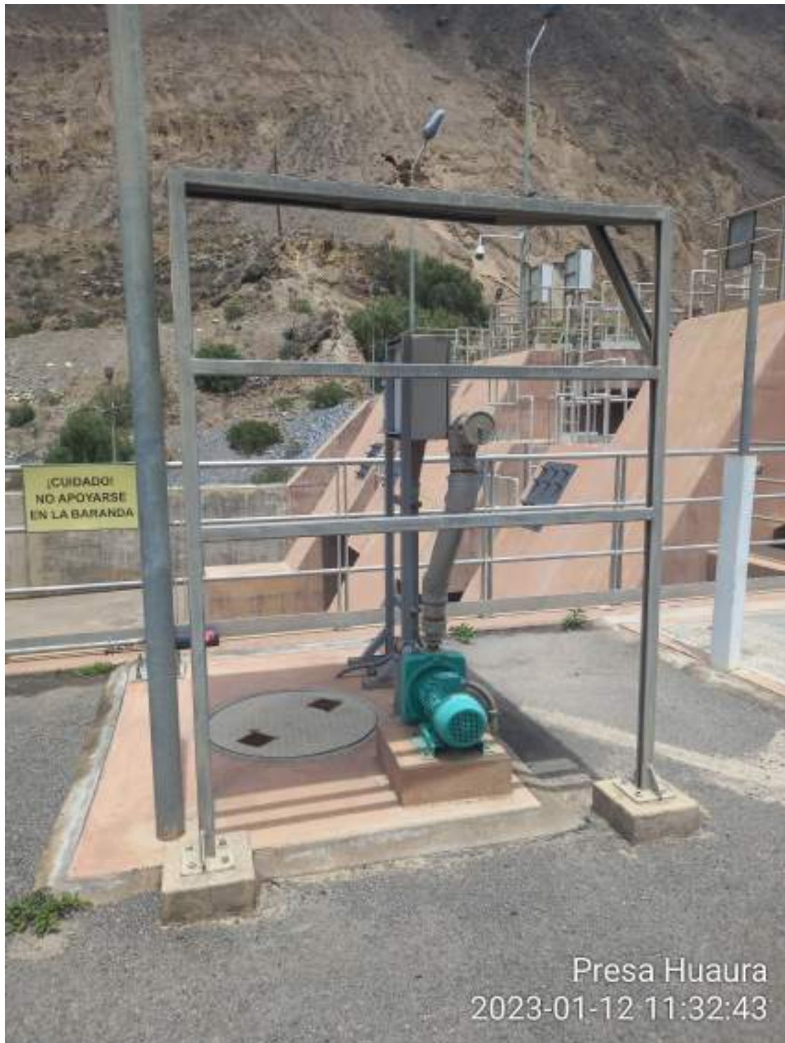
Figura 3-20 Vista actual del pozo ciego 1 (Toma Huaura)
