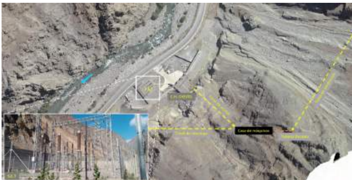
Figura 5-3 Llegada de las aguas de Checra para la generación de energía eléctrica en la CH Cheves
