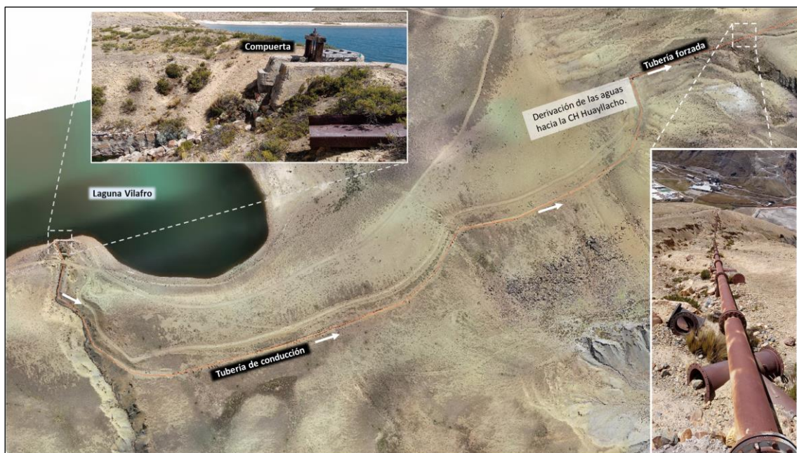
Figura 5-1 Captación de las aguas de la laguna Vilafro
