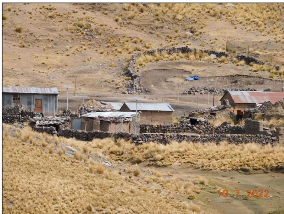
Fotografía 1: Vista general de la estancia Ccucho Quipa Vilafro. Se puede observar las viviendas de adobe con techo de calamina, también se puede visualizar que cada una de las viviendas cuenta con un panel solar. Por otro lado, también se llegan a apreciar los corrales de piedra y alambre.
