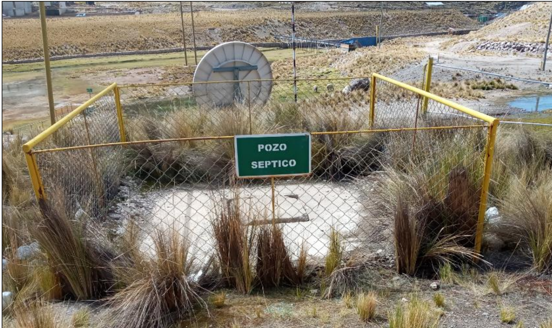
Fotografía 3.3-3 Vista actual de Pozo séptico
