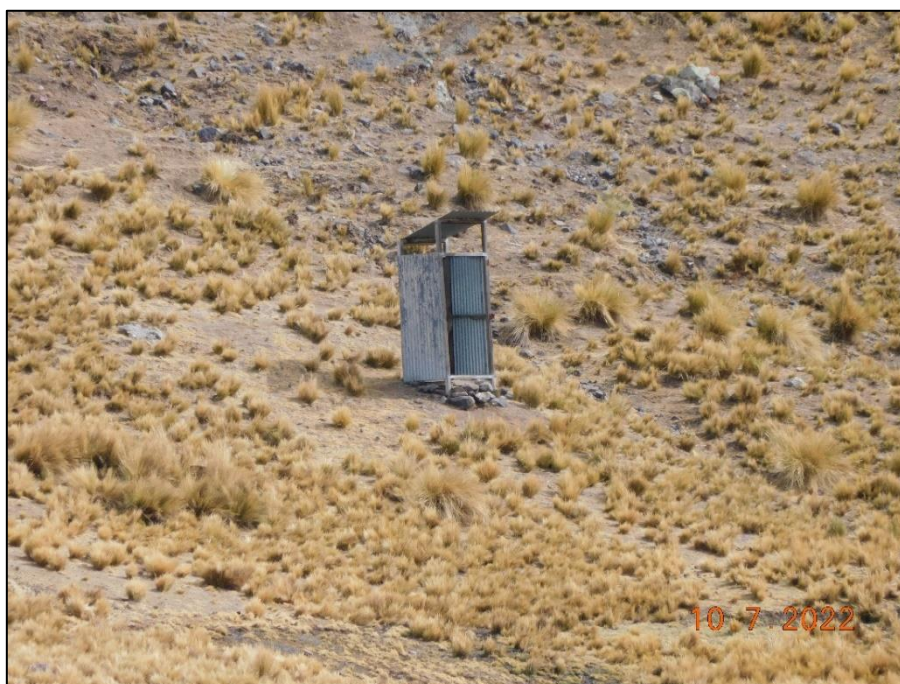
Fotografía 3: Letrina de estancia Ccucho Quipa Vilafro. La letrina que se puede apreciar en la imagen es la única, en buen estado con la que cuenta la estancia.
