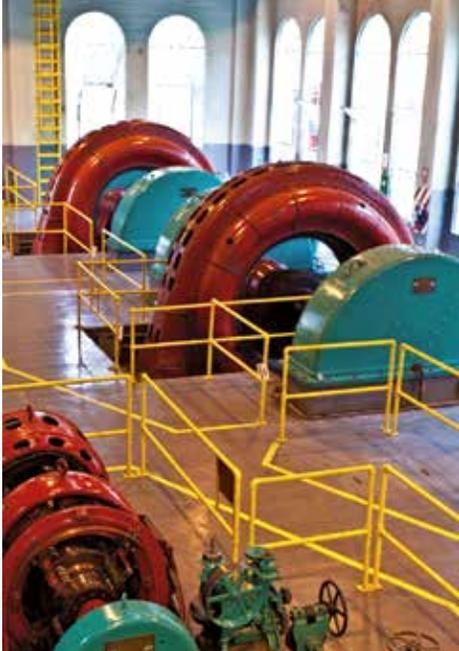
Parte interna de la sala de máquinas de la central, donde se aprecia los generadores 2 y 3 con sus respectivas turbinas. Se puede notar el buen estado de conservación de las unidades de generación.
