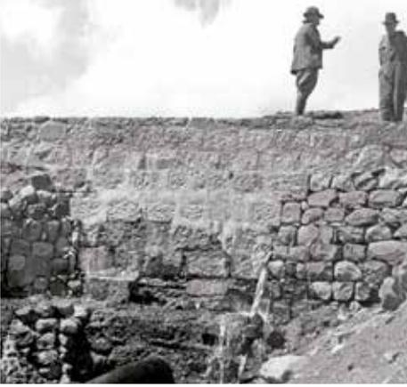
Bocatoma con tubería de ingreso mostrando filtraciones.
