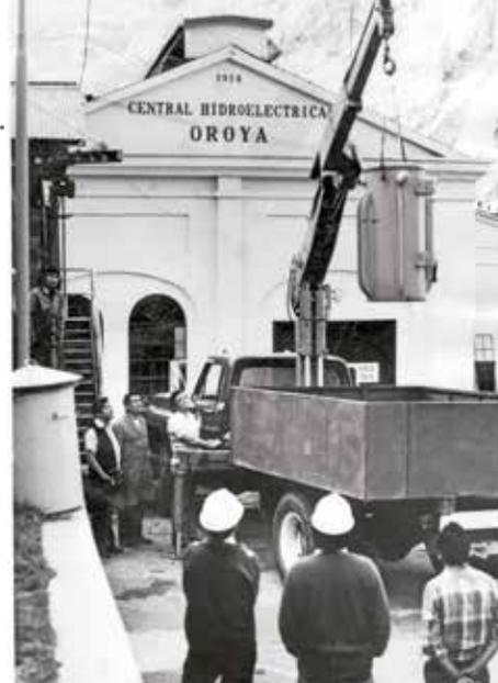
Instalación de autotransformador para Subestación Oroya, 1981.
